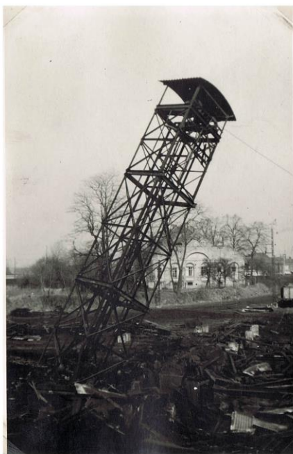
7. Démolition du châssis à molettes en 1955
