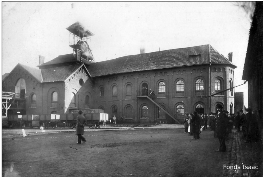
Vue des bâtiments du Grand-Trait
